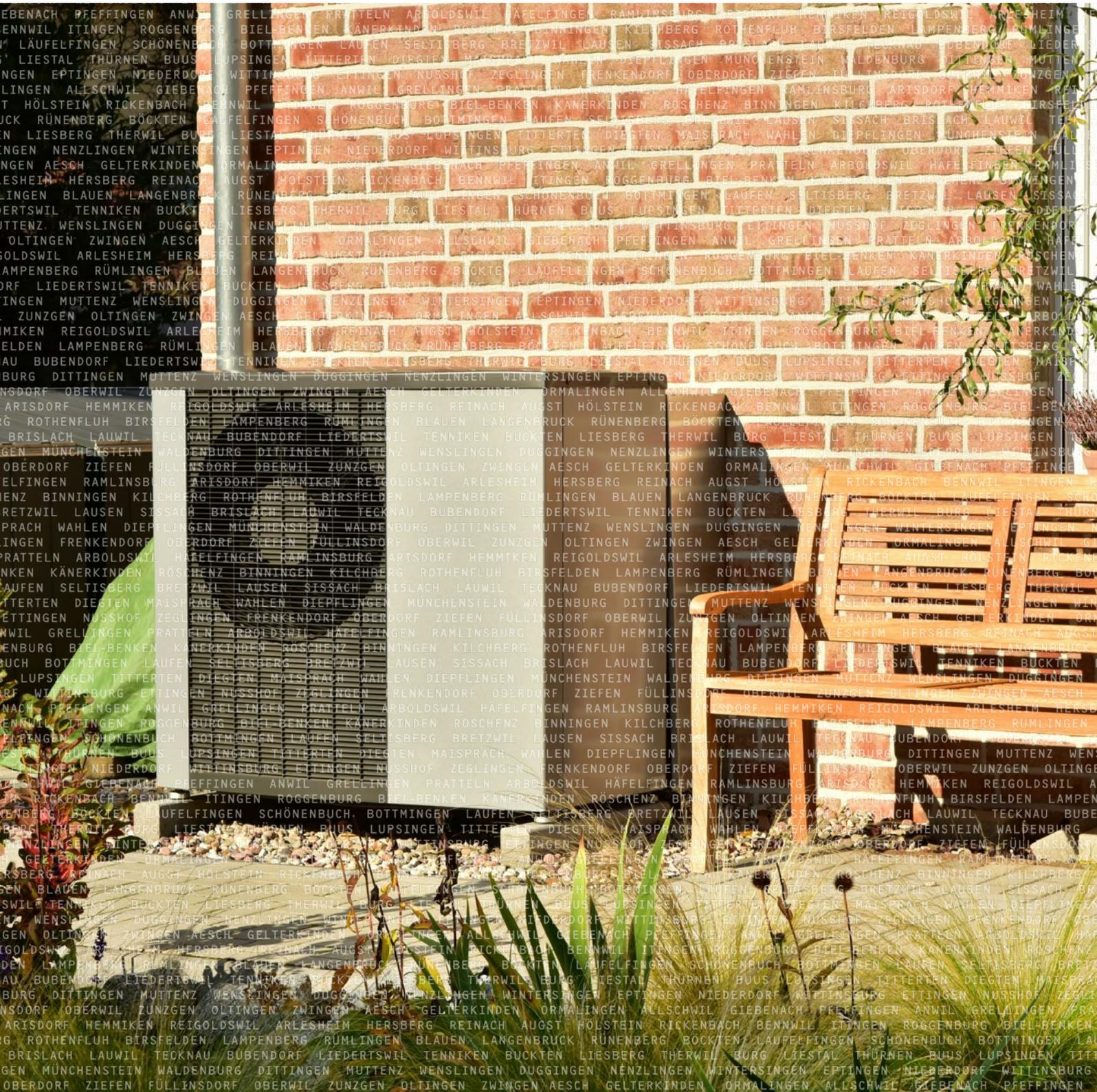
**Luft / Wasser-Wärmepumpen – dies gilt insbesondere für aussen aufgestellte Anlagen – können zu Lärmproblemen in der Nachbarschaft führen. Dieses Merkblatt soll helfen, die Aufstellung von Luft / Wasser-Wärmepumpen so zu planen, dass die gesetzlichen Anforderungen in Bezug auf den Lärmschutz erfüllt und kostspielige Nachrüstungen von Lärmschutzmassnahmen vermieden werden können.**
