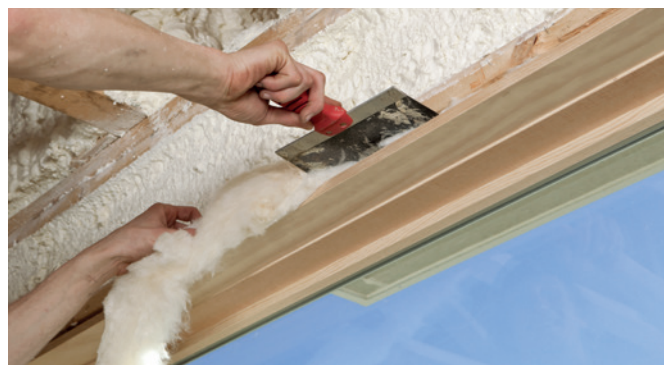
Stopfen der Fugen mit weichem Material
